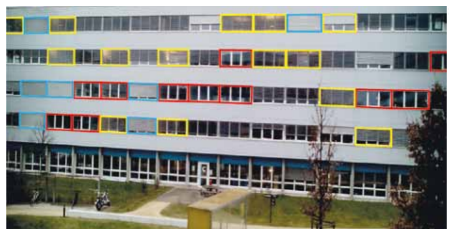
L'utilisation des stores est très aléatoire. Par temps couvert, seule une petite partie d'entre eux sont en position correcte (en rouge). D'autres sont complètement baissés (en bleu). Pire, des lampes sont allumées alors que les stores sont partiellement baissés (en jaune).
