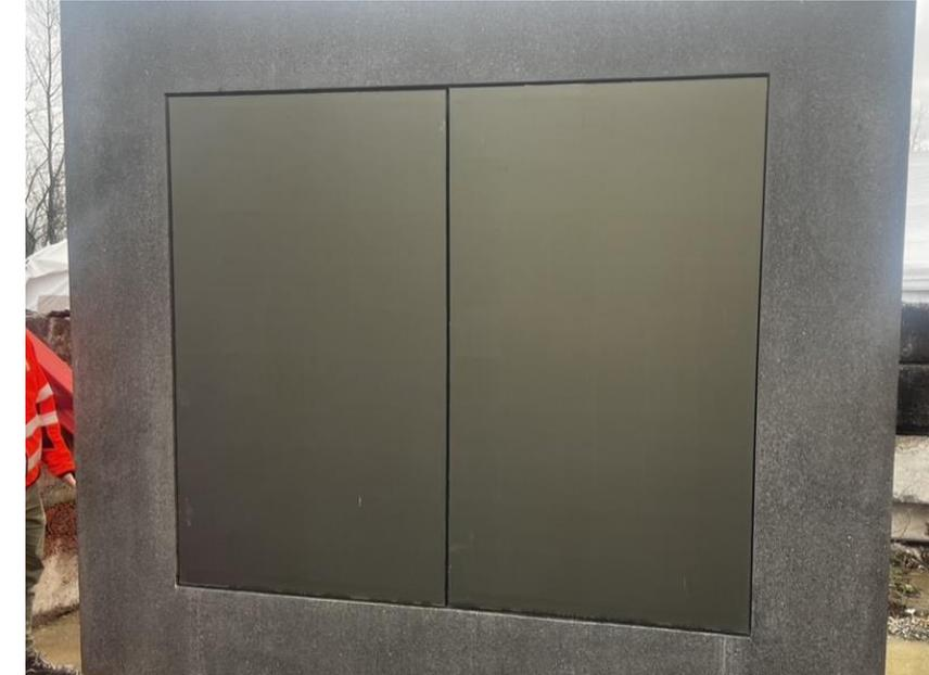
*Module avec panneau photovoltaïque intégré*
